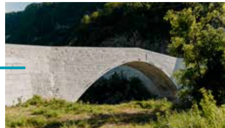
Restauration du Pont Vieux, financée par le Conseil Départemental de la Haute-Savoie
